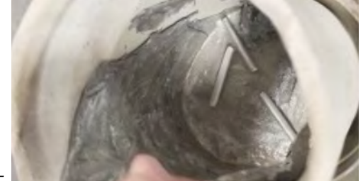
Esta piel contiene óxidos y deben quitarse antes de cargar la cuchara
