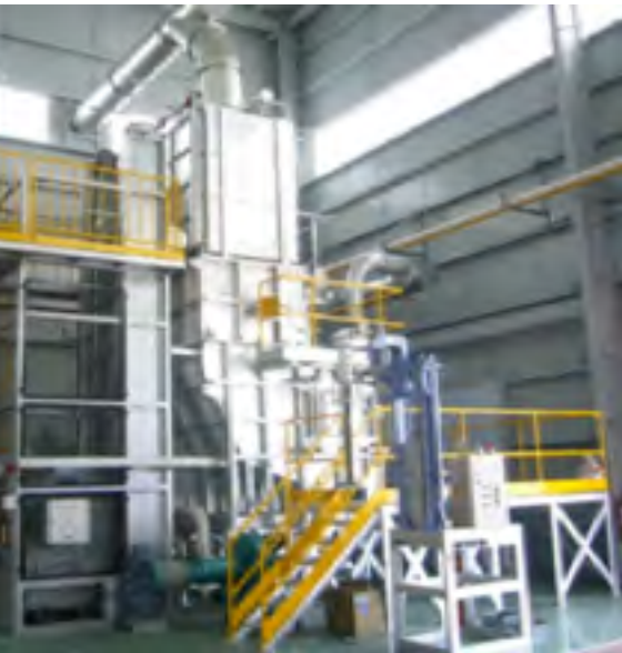
Horno de Fusión en Torre o Stack
