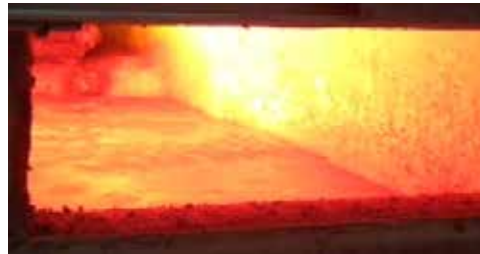
Muestra B: Revestimiento de 3 años de horno limpiado apropiadamente
